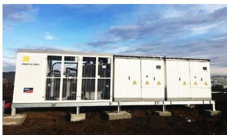
Photo des onduleurs utilisés (modèle indicatif et fonction du projet)
