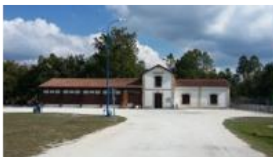
Ancienne gare, aujourd'hui gymnase
