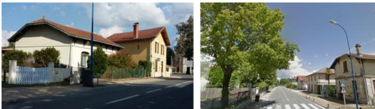
Séquences bâties à l'alignement dans le centre-bourg
