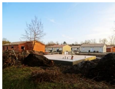
Lotissement en construction à St-Magne en déconnexion avec le tissu urbain existant
